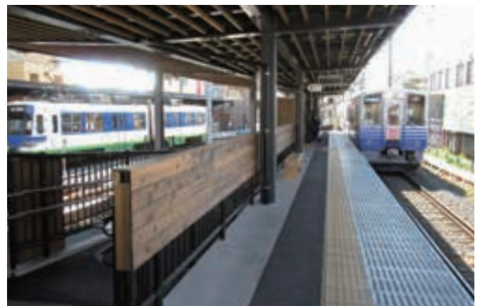
全ての列車が相互乗り入れされているわけではないため、相互乗り入れされない列車は乗り換えがスムーズにできるようダイヤが組まれている。福井鉄道(左奥)とえちぜん鉄道(右)。
