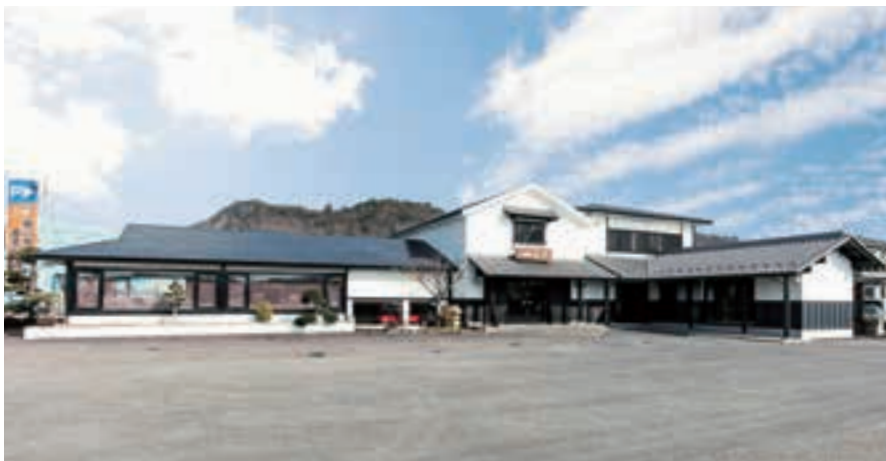
関刃物ミュージアムの全景
