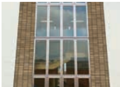
リサイクルタイルの施工事例② 多治見市立精華小学校付属愛児幼稚園
