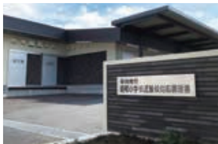
リサイクルタイルの施工事例① 多治見市立昭和小学校
