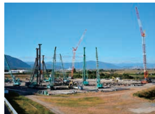
写真2 工場建設が進む駒野工業団地 (2023年10月、筆者撮影)
