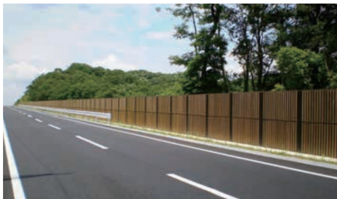
木製防音壁「安ら木」 地域の木材を使用。優れた防音性能と景観に調和するデザイン性が魅力。
