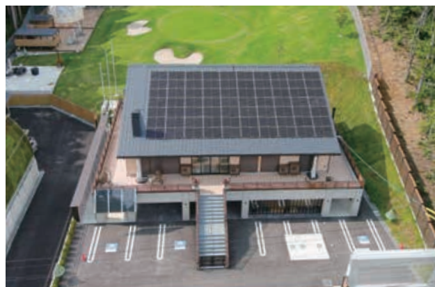
太陽光発電システム 年間発電量は約30,000キロワット。宿舍棟やEV充電器の電力を賄う。
